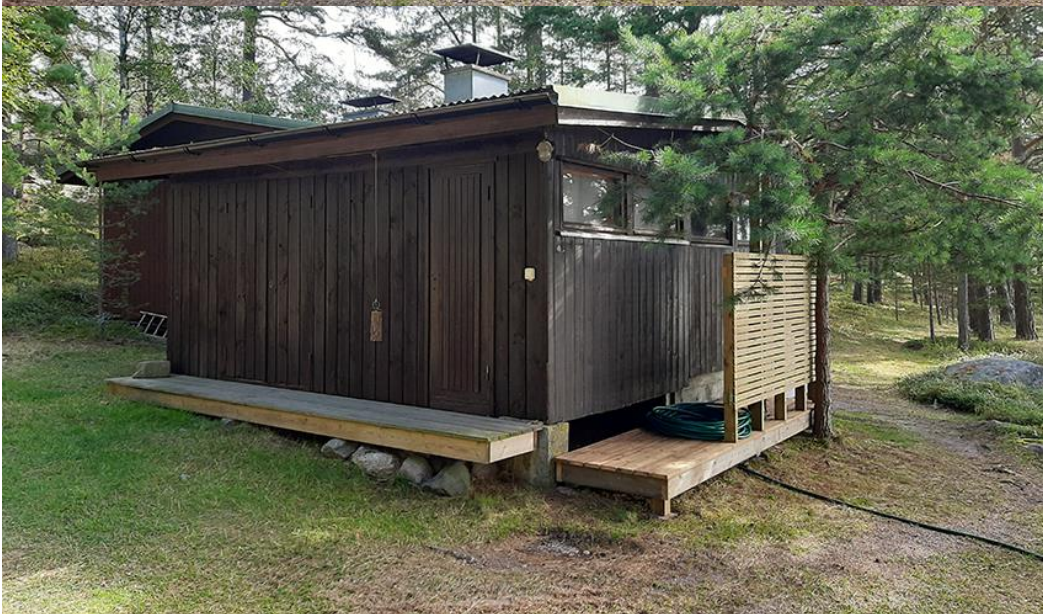
Kuvat 16-17. Korttelin 7 rakennuspaikan 1 päärakennus mereltä ja sisämaasta kuvattuna.
