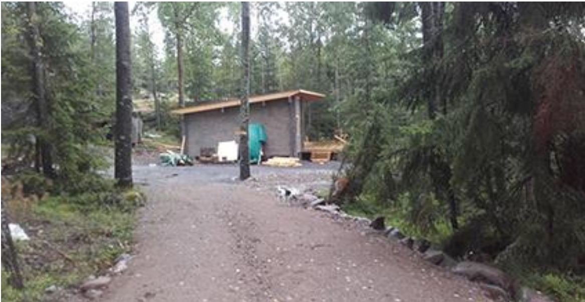
Kuva 12. Korttelin 5 rakennuspaikalla rakenteilla oleva uudisloma-asuntorakennus.
