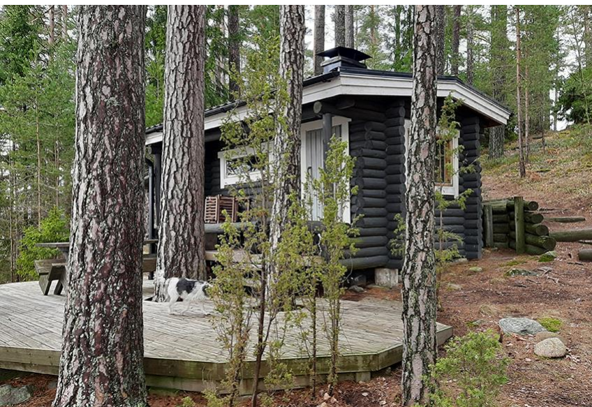
Bilder 15-17. Huvudbyggnaden, sidofritidsbostaden och strandbastun på byggnadsplats 3 i kvarter 3.
