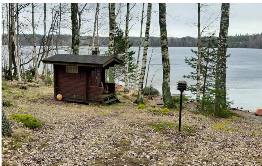
Bild 19. Strandbastun på byggnadsplatsen ovan.
