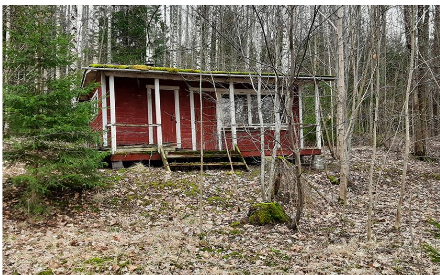
Bild 20. Bastubyggnaden på byggnadsplats 6 i kvarter 3.
