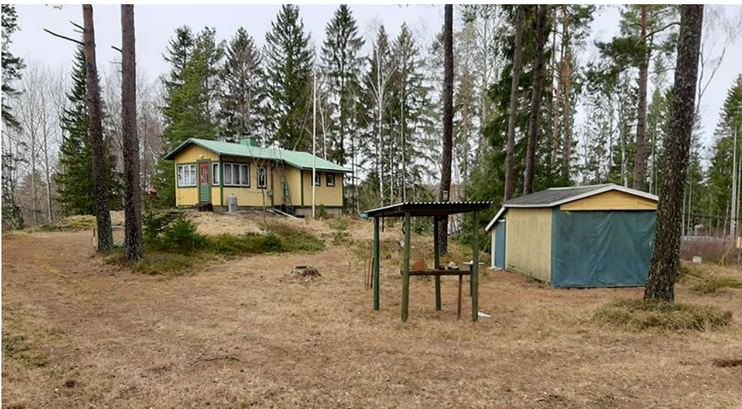
Kuva 14. Korttelin 3 rakennuspaikan 2 kesämökki ja autotalli.
