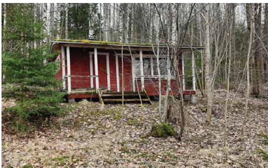
Bild 20. Bastubyggnaden på byggnadsplats 6 i kvarter 3.
