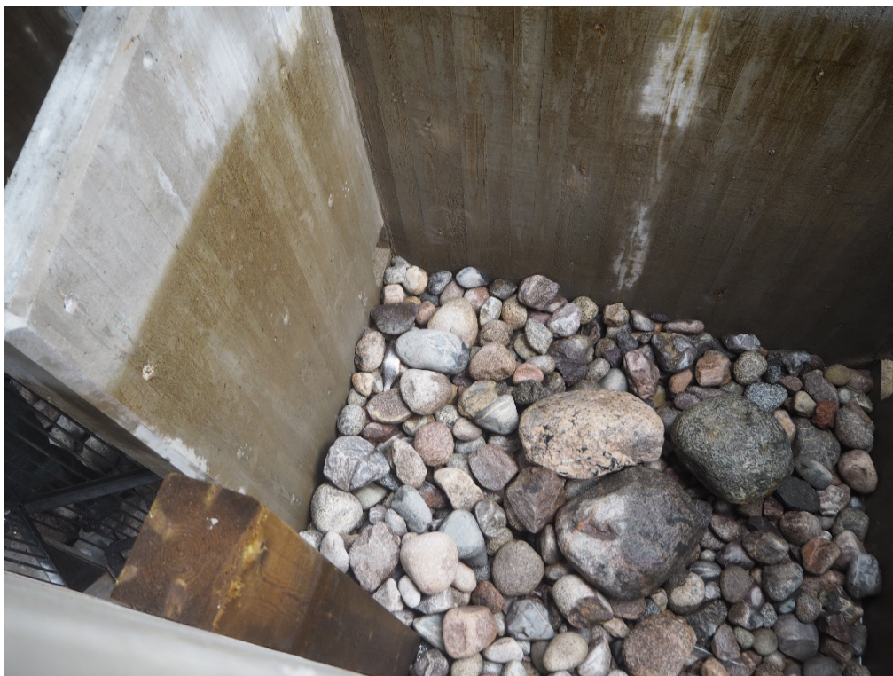
Kuva 3. Äminneforsin kalatien allas. Kalatien pohja on luonnonkiveä. Altaiden välisissä seinämissä on pystyraot sekä ryömintäaukko.
