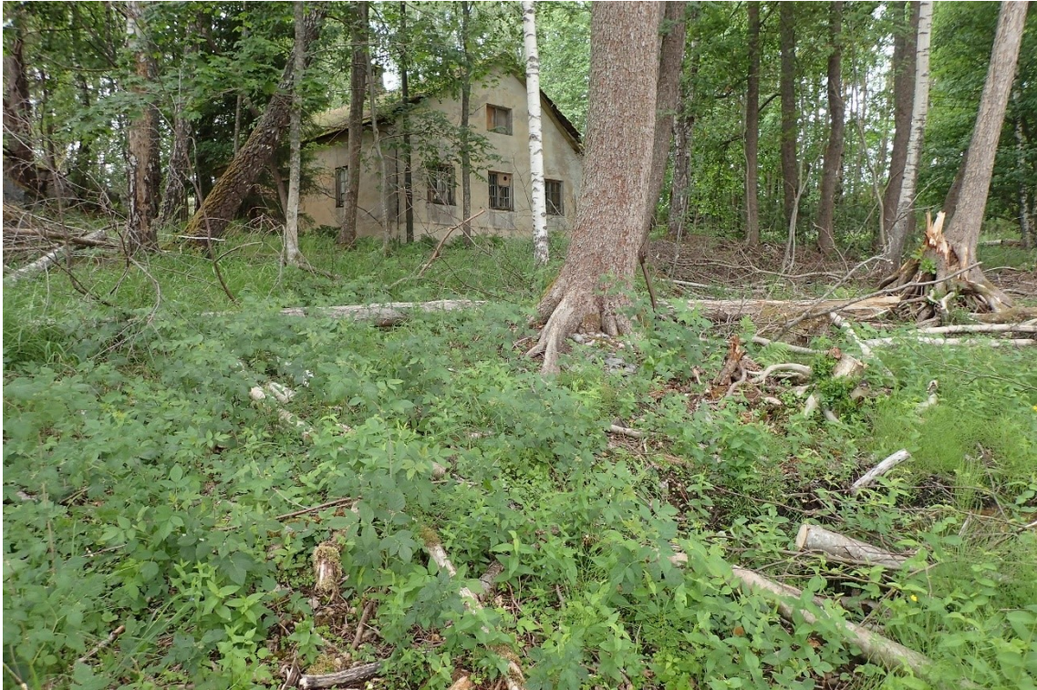
Kuva 27 Liito-oravalle jokseenkin soveltuvaa puustoa kasvaa vanhan paloaseman ympäristössä. Kuvassa keskellä näkyy järeä tervaleppä.
