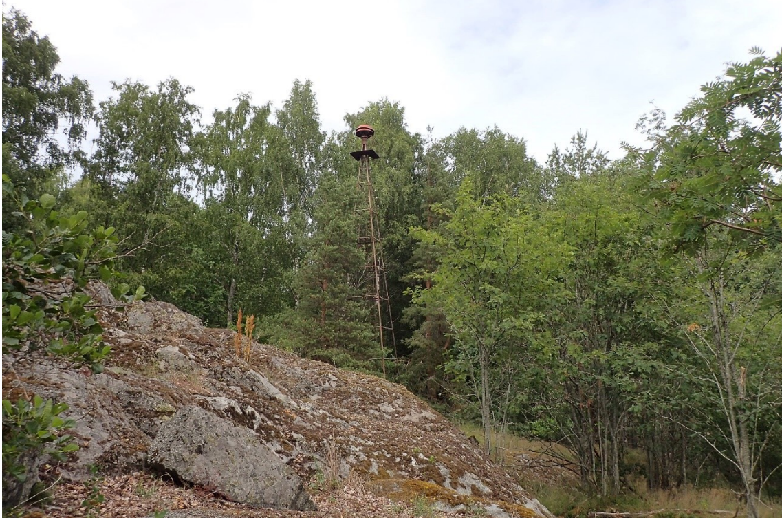
Kuva 10 Avokalliolle kuviolla 11 on rakennettu palokello.
