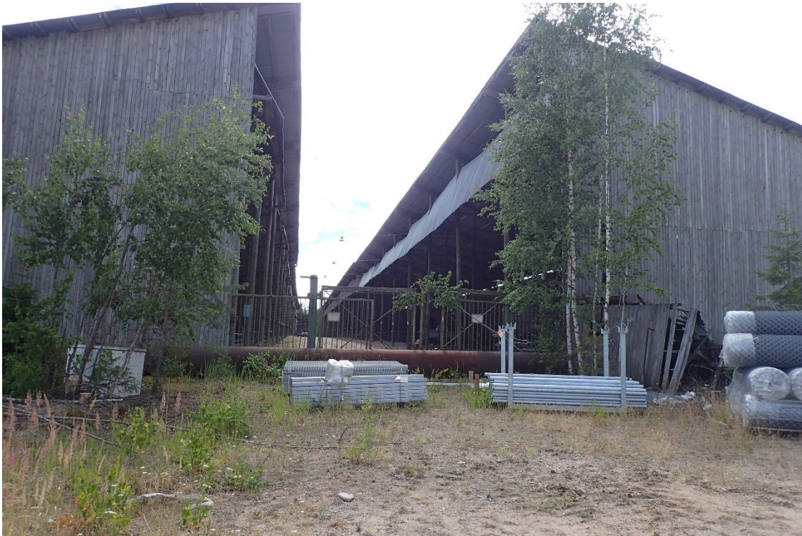
Kuva 21 Varastorakennukset toimivat pääskyjen pesäpaikkoina.
