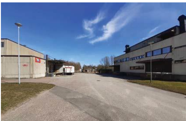
Figur 27. Garnisonsgatan. Tvätteriets lastningsplats till vänster på bilden och kantinbyggnaden till höger.
