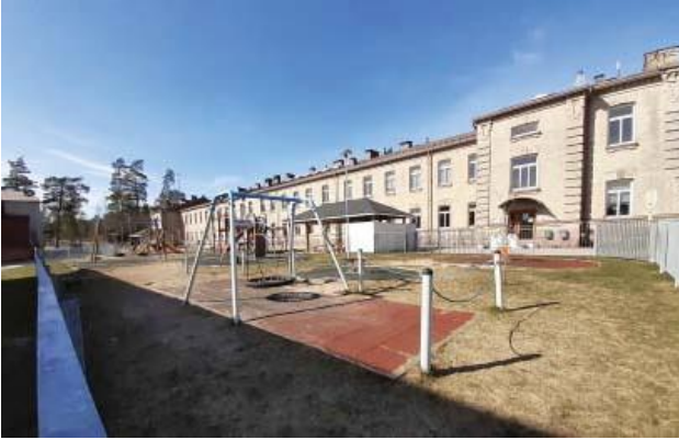
Figur 18. Före detta manskapskasern, sr-1 (10).
