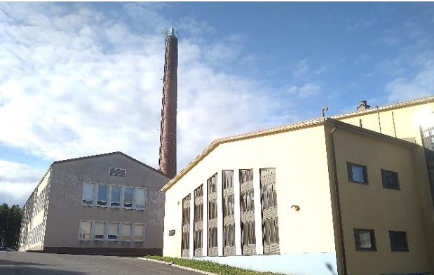
Figur 19. Före detta kosthåll sr-1(11) och värmecentral sr-1(12).
