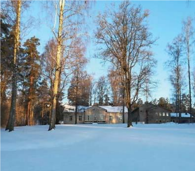
Figur 15. Före detta överläkarbostaden, sr-1(3).
