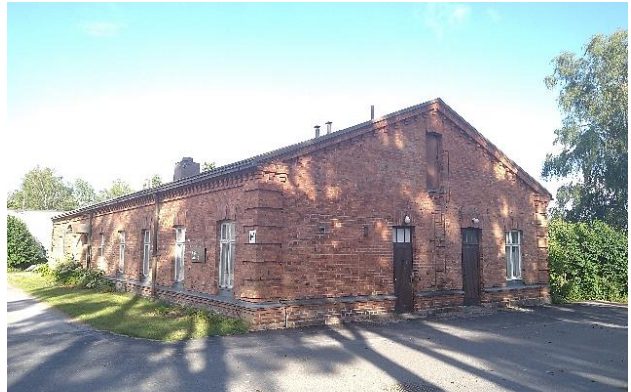
Figur 20. Före detta bageriet sr-1(13).
