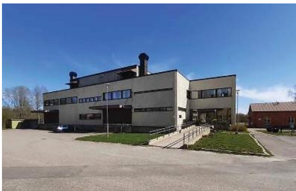
Figur 21. Kantinbyggnaden ("J"-huset), framsidan.
