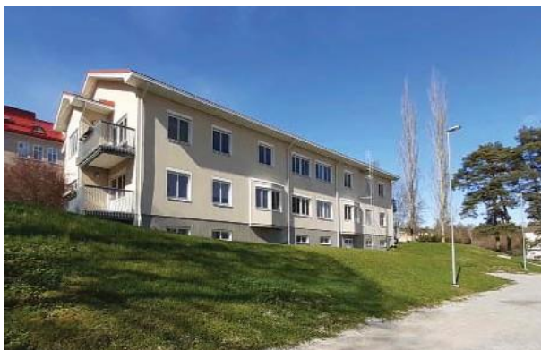
Figur 22. Tilläggsbyggnad söder om huvudbyggnaden.
