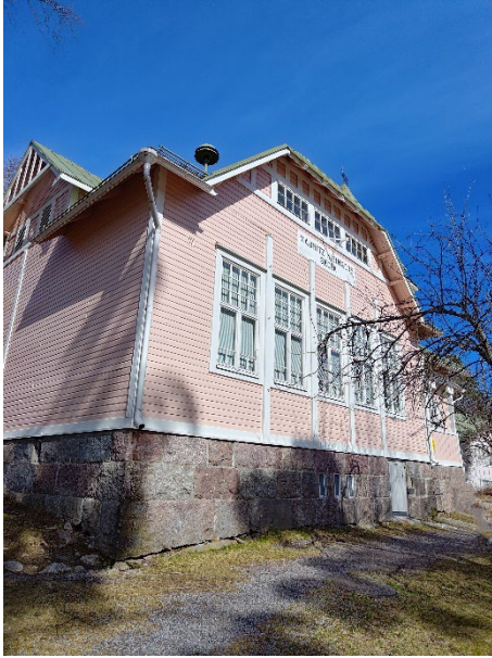
Bild 8. Den gamla skolbyggnaden från 1904 totalrenoverades år 1990.
