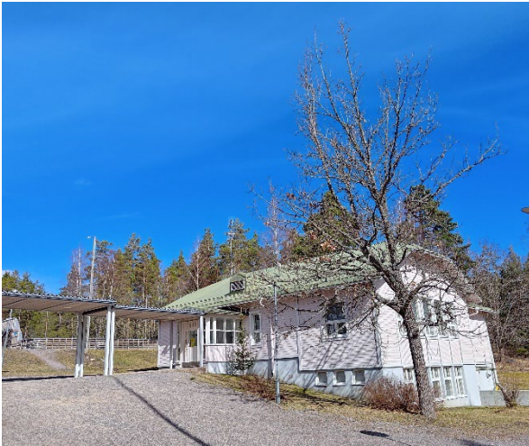
Bild 9. År 1990 byggdes en ny skolbyggnad invid den gamla skolbyggnaden.
