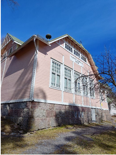
Bild 6. Den gamla skolbyggnaden från 1904 totalrenoverades år 1990.
