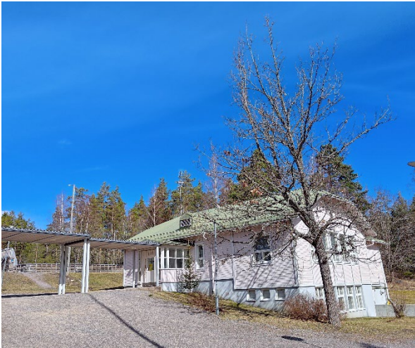
Bild 7. År 1990 byggdes en ny skolbyggnad invid den gamla skolbyggnaden.
