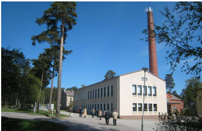
Bild 71 Byggnad L sedd från huvudbyggnaden.
