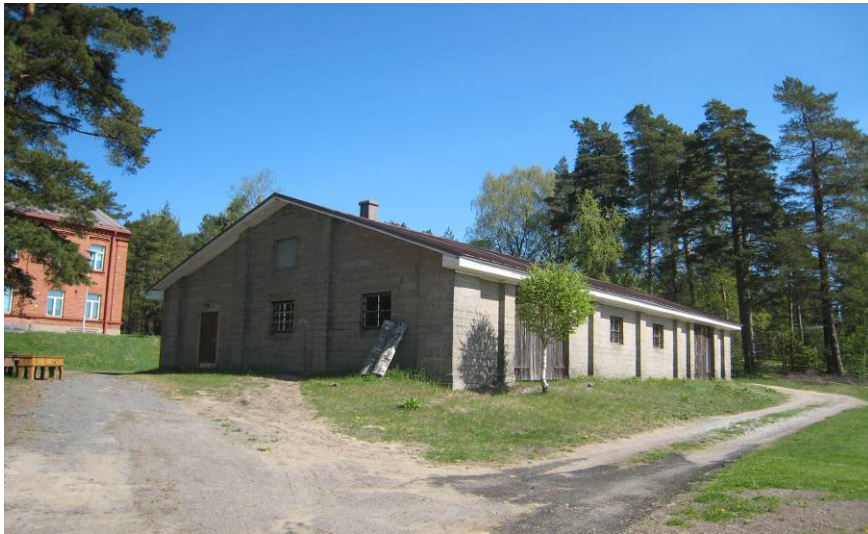
Bild 98 Den kalla förrådsbyggnaden.
