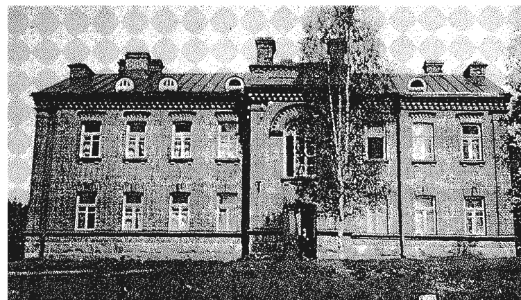
Bild 88 Torpet före utvidgningen (Bild i källan Törrönen 1985 s.46). Om man jämför bilderna på denna sida upptäcker man att takfönstren har ändrats i samband med renoveringen av taket. Balkongen är också ett senare tillägg.
