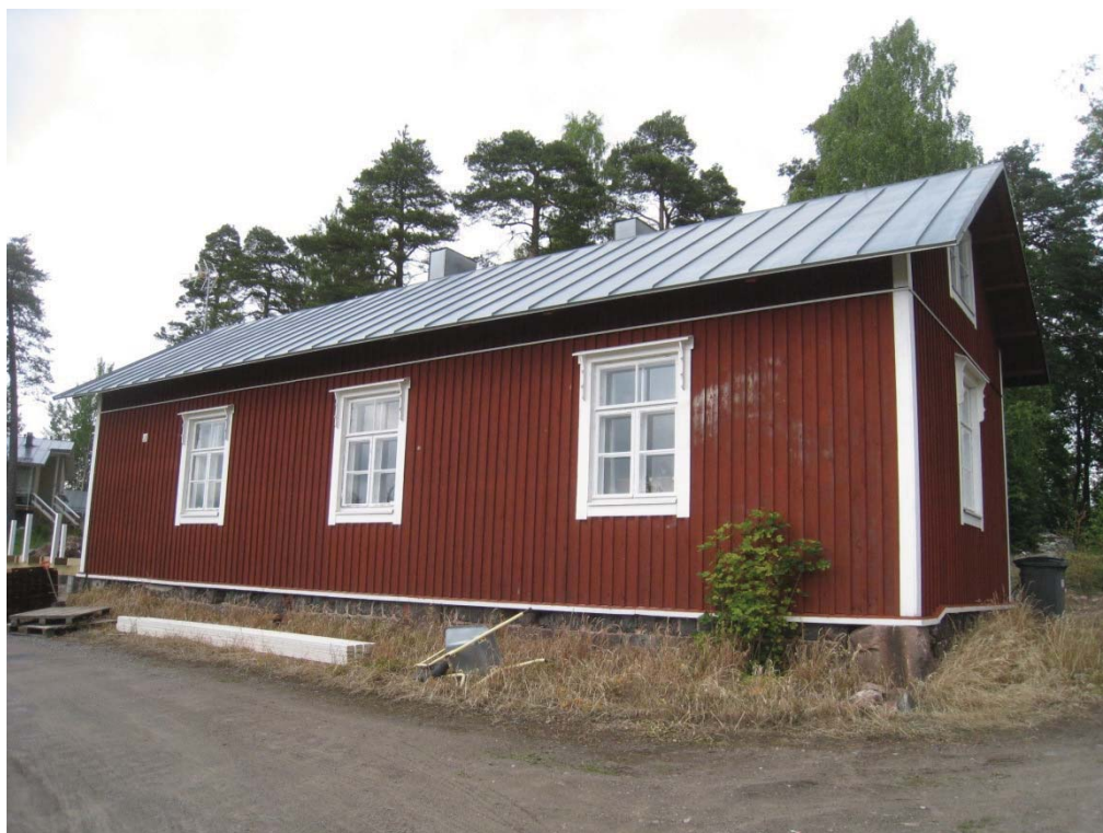
Kuva 5: Nykyistä rakennuskantaa: 2a.
